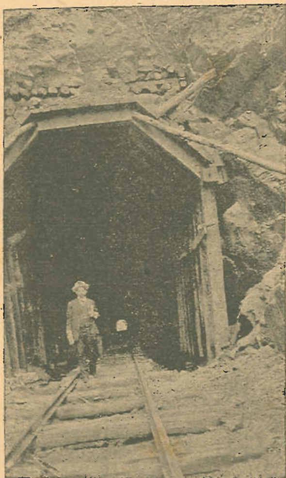
TUNEL DE CAMBALACHE (VIA AL PACÍFICO)
