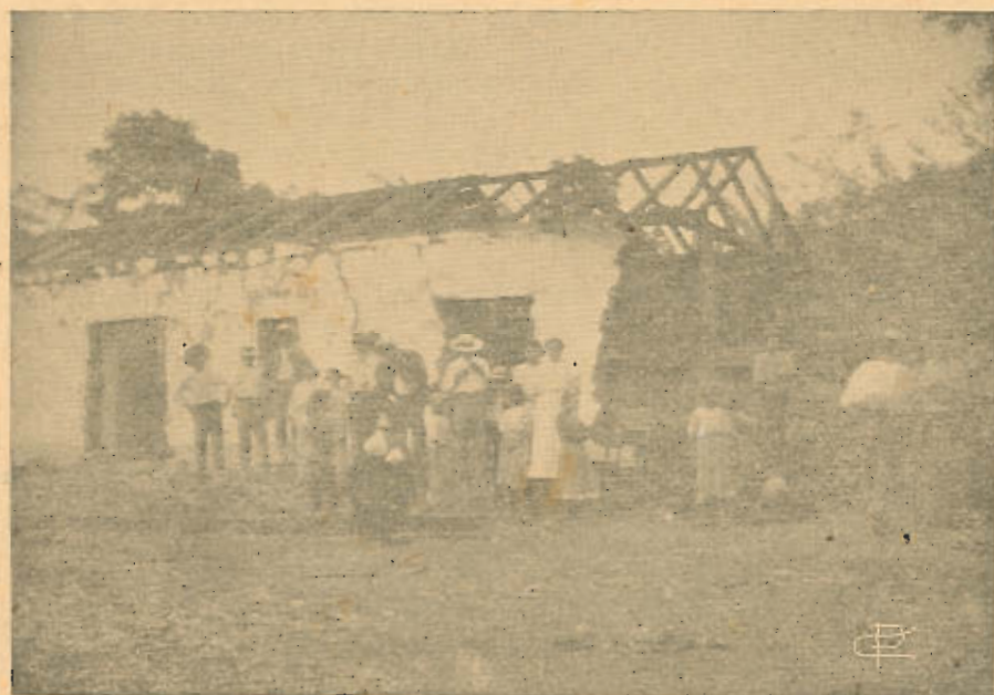
CASA DE CONSTRUCCIÓN EMPÍRICA DAÑADA POR UN TEMBLOR
